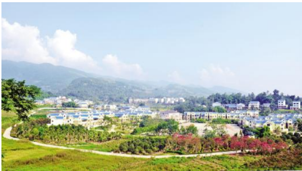
庙坝镇长乐村新农村综合体全貌
