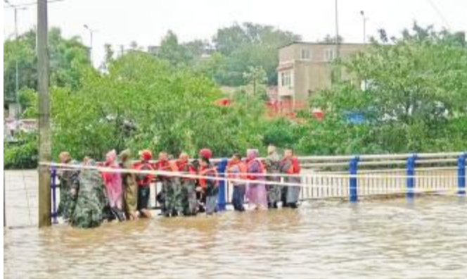
撤除跨河大桥的栏杆确保洪水顺利过堤
