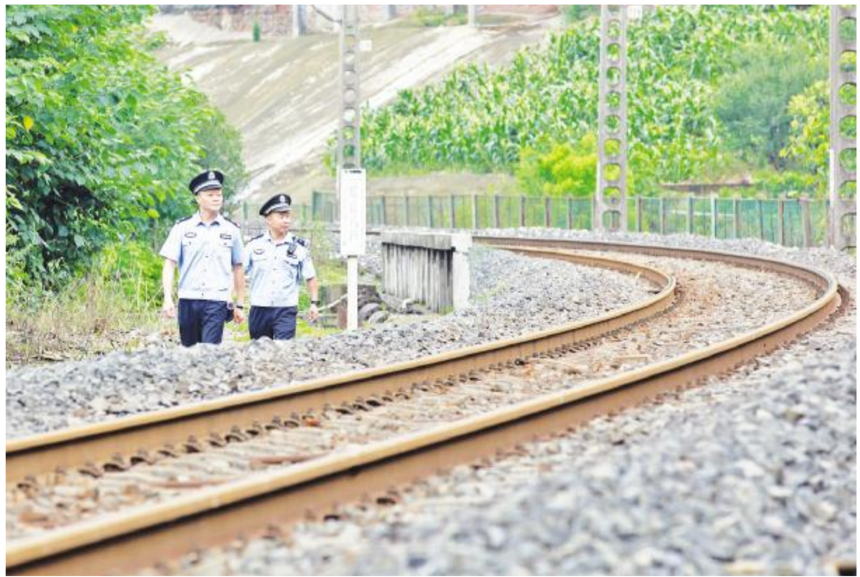
2名民警在宝成铁路绵阳段开展巡防,排查汛期安全隐患。
