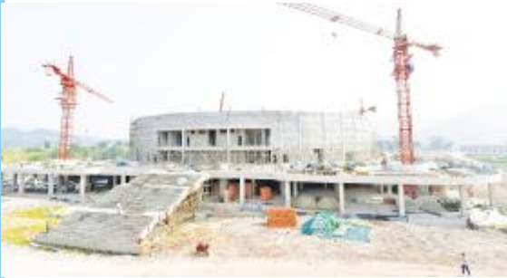
加快建设的渠县公共文化中心一期体育馆项目外景
