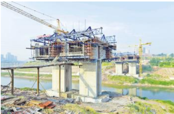
在建的渠县流江河交通景观桥
