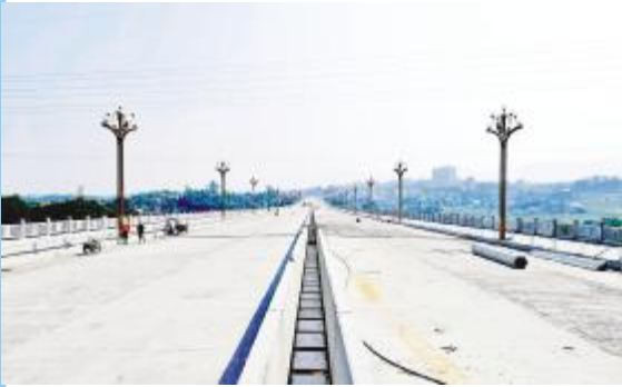
即将竣工的渠城至渠县火车站快速通道
