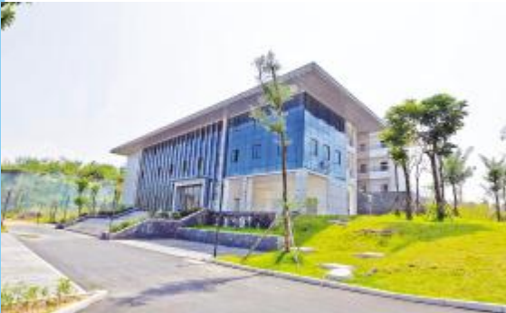
建成的渠县医养教服务中心
