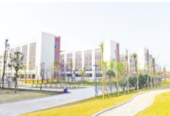
连廊式教学楼
