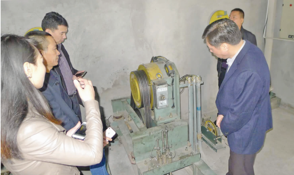
质检人员对小区电梯进行评估
