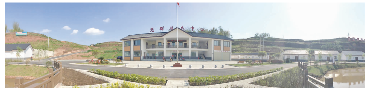
瓦市镇沙溪村党群服务中心
