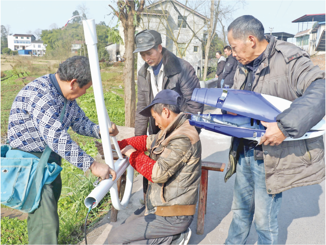
安装太阳能路灯
