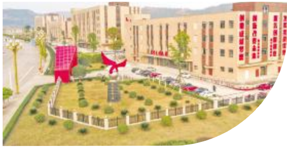
鸟瞰建设中的园区
