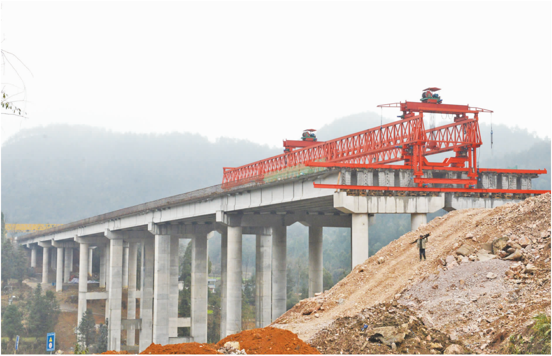
石旰至玉屏(大龙)高速公路岑巩县天马镇横溪大桥建设项目现场
