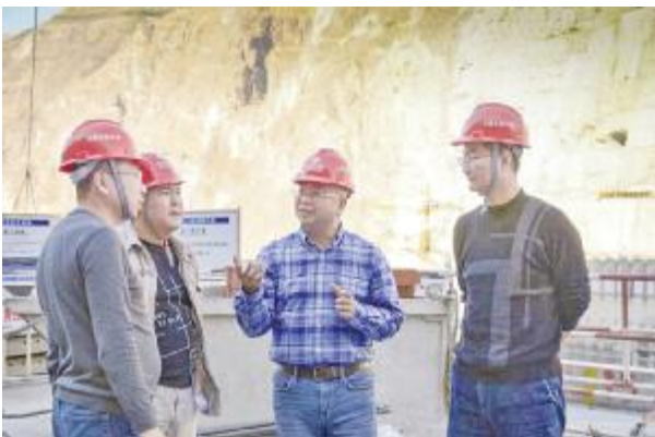
吴兴国(右二)视察在建工地
