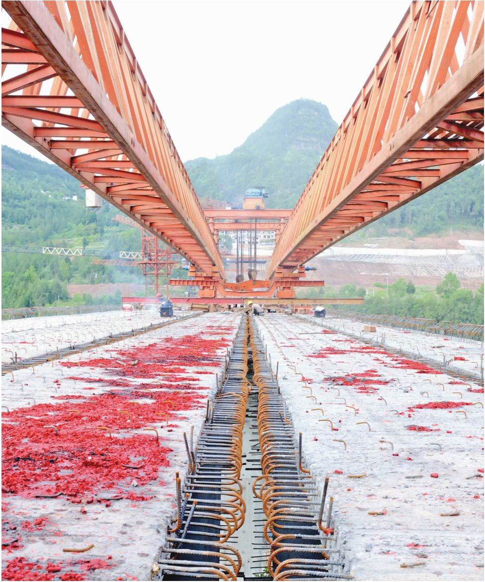
工人在洞坎河大桥上施工
