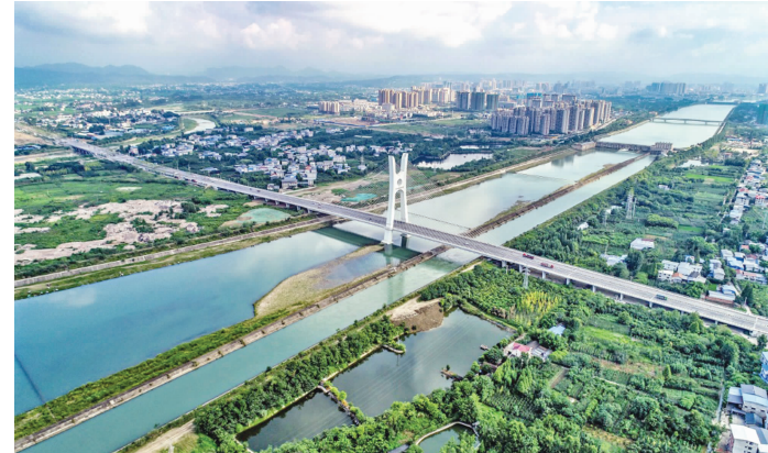
涪江五桥航拍图
