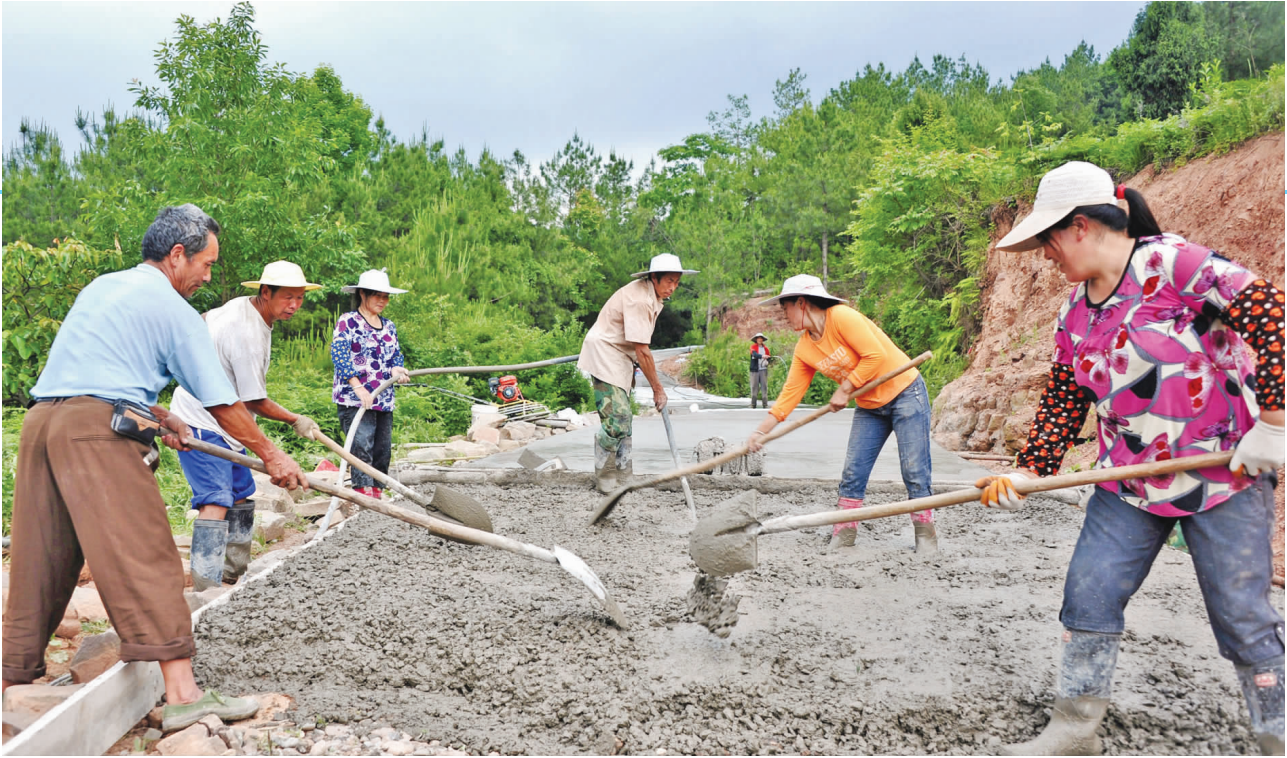
近日，四川省南江县平岗乡槐杆村村民在施工硬化通组公路。近三年来，地处边远山区的平岗乡共计新建、改建和硬化通村通组公路320多公里，新建桥梁10余座，把贫困山村的“慢交通”变为“畅交通”，助推了美丽乡村建设和乡村振兴。
