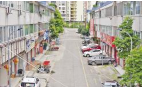
芙蓉小区每条小巷都安装了全新的路灯
