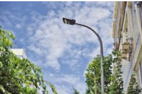
改造升级后的小区路灯
