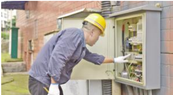
工作人员对路灯配电箱做日常维护
