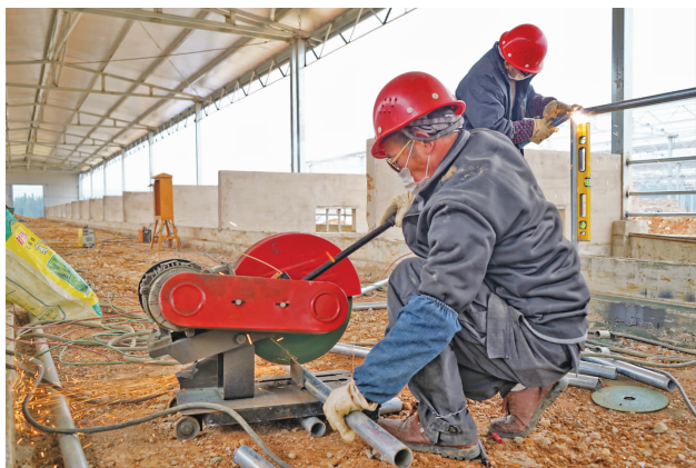
项目施工现场
