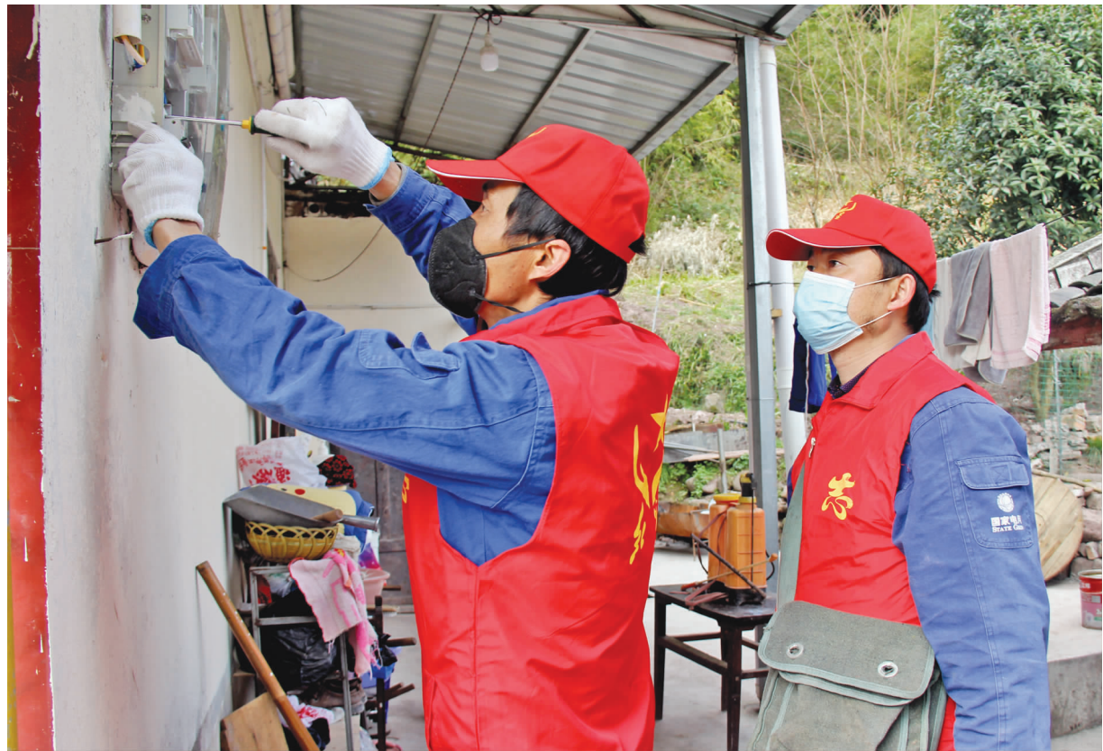
近日，国网通江县供电公司“红星”志愿者在位于四川省巴中市通江县陈河乡陈家坝村的一家生态科技公司陈河基地里检修电路。连日来，国网四川省电力公司通江县供电公司紧紧围绕解决脱贫攻坚中突出问题，加快供区深度贫困乡镇电网改造升级，开展“电力走进产业”等活动，为企业产业扩大规模等提供电力保障，助推地方打赢脱贫攻坚战。
