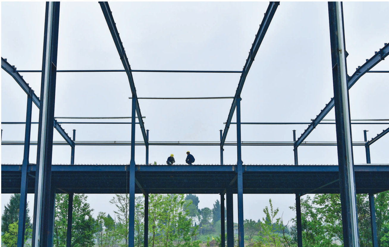
4月5日,在四川省广安市广安区大安镇中兴绿丰柠檬加工厂建设现场,工人正忙碌地安装和焊接钢结构厂房。为提升柠檬产业发展效益,解决柠檬果销售难题,广安区通过金融贷款、土地调规、项目支持等举措,支持帮助业主建设深加工企业,建成后年可加工柠檬2万吨以上。目前,广安区已规模发展柠檬产业3.2万亩,小柠檬已成为助推脱贫攻坚和乡村振兴的千亿大产业。
