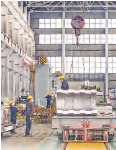
桥梁部件吊装现场
