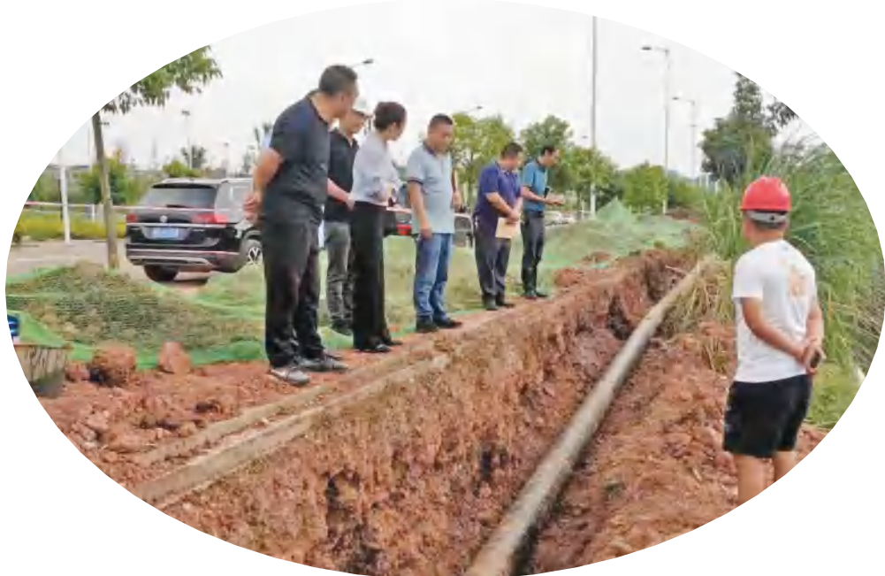
该工程为 2021—2023 年全域供水基础设施改造工程，属 2021 年仁寿县政府挂图作战项目，2021 年 8 月 15 日开工建设，12 月 31 日竣工。图为项目建设中。
