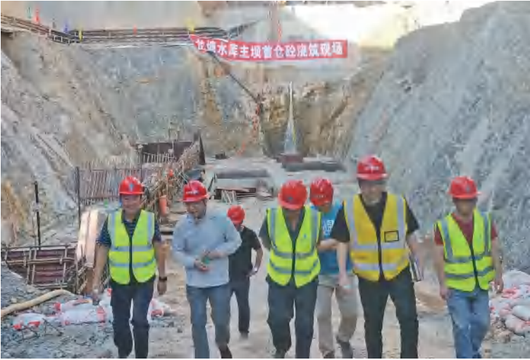
支部书记、经理毛伟和同事在施工现场
