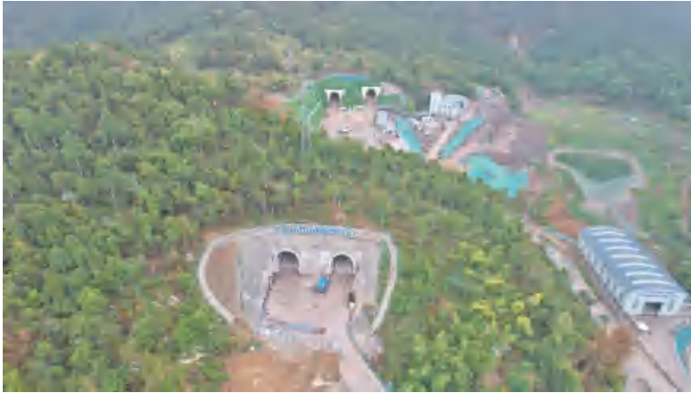
轨道交通 27 号线施工现场 曾清龙 摄
