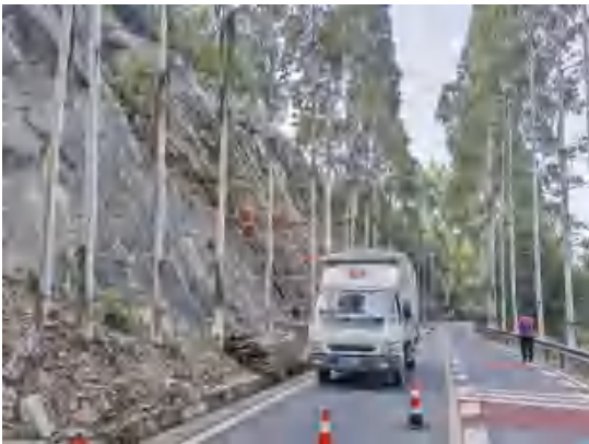
S107 公路养护工程施工现场 曾清龙 摄
