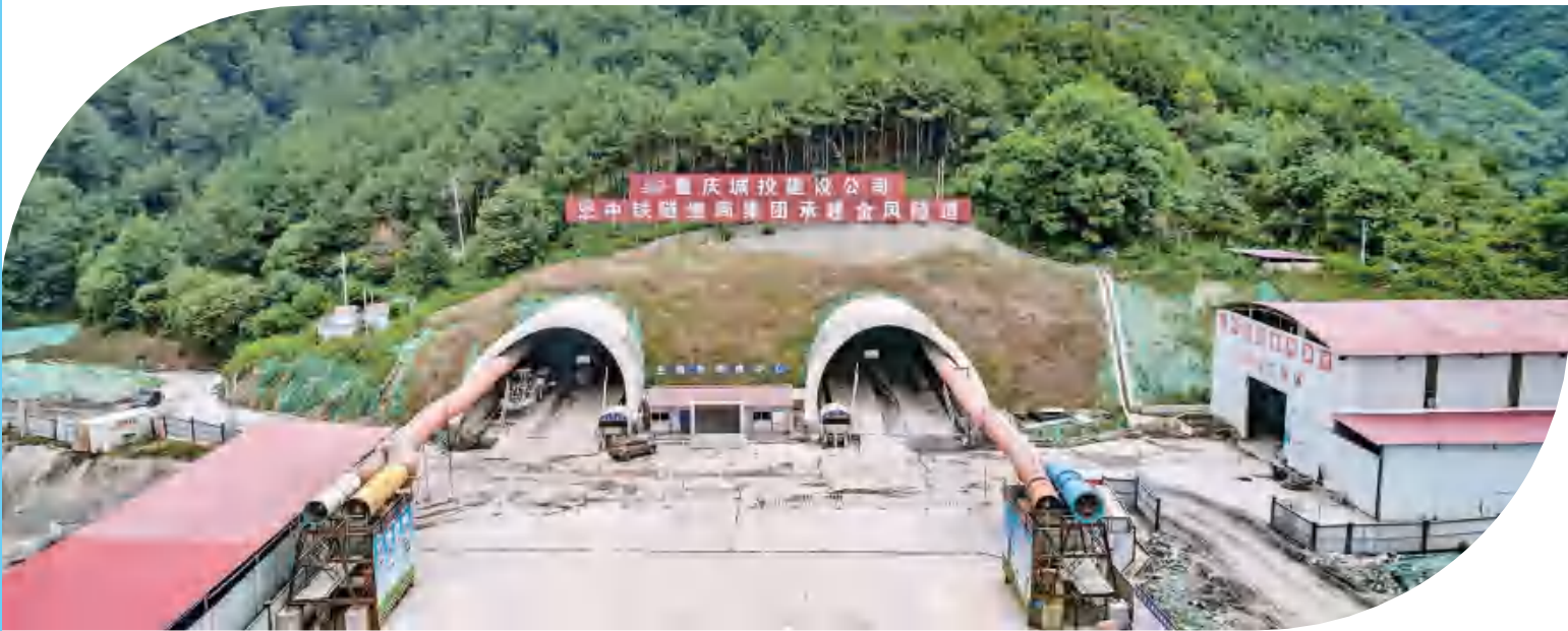
金凤隧道璧山进口施工现场 曾清龙 摄
