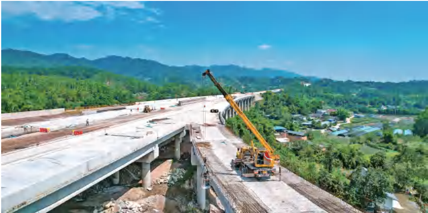
合璧津河边坡施工现场 曾清龙 摄
