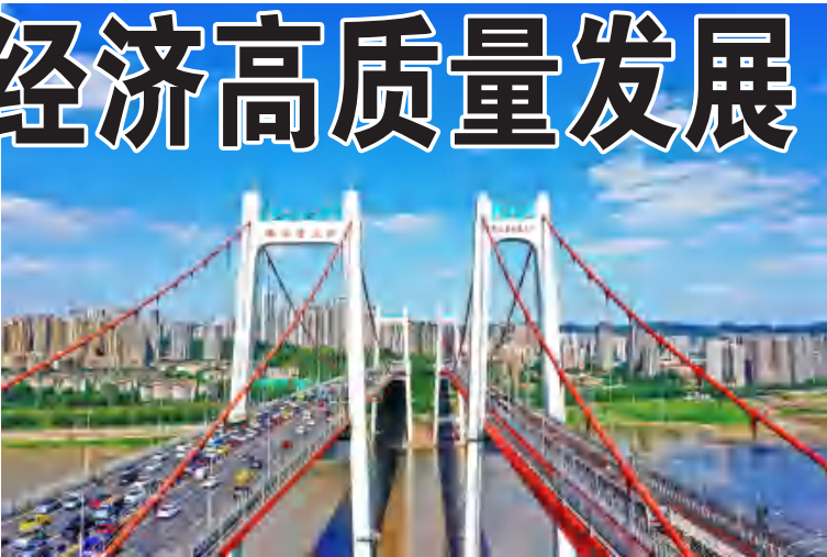
重庆鹅公岩轨道、公路专用桥
