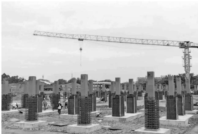
了隐蔽验收,现在正在进行模板安装工作,随后将浇筑混凝土。
