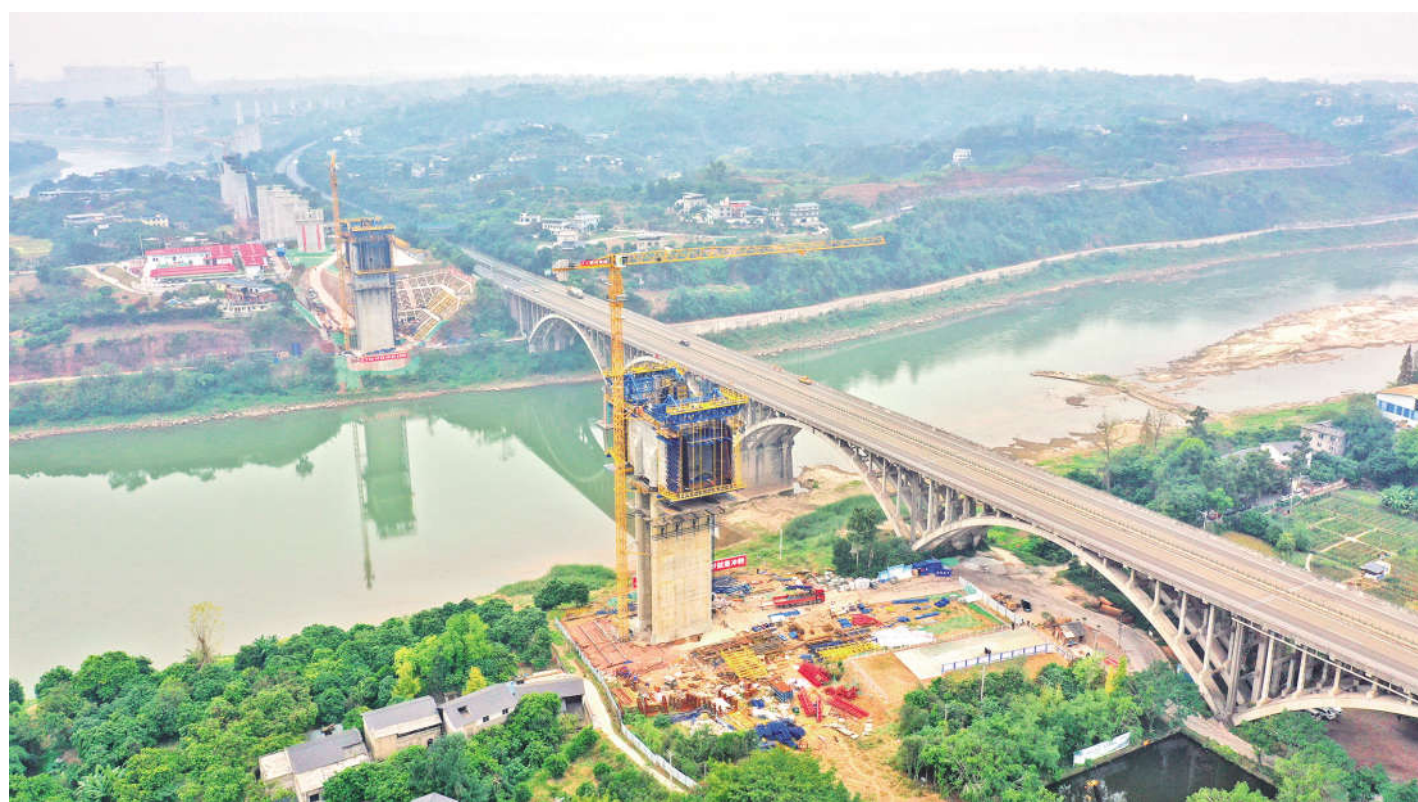
12月7日,在位于四川省泸州市龙马潭区的隆黄铁路泸州沱江铁路特大桥项目建设现场,工人们正在距离江面近百米的高空中忙碌施工。 泸州沱江铁路特大桥作为隆黄铁路(隆昌至叙永段)扩能改造工程的重点控制性工程之一,全长2408.72米,是国内最大跨度的铁路单索面斜拉桥,是四川南向出海便捷货物运输通道,未来将肩负“四川—贵州—广西”最近出海铁路货运大通道的重任。
