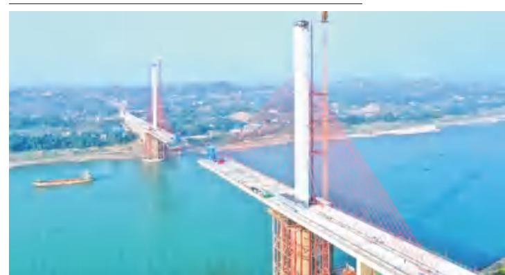
又一座创世界纪录的“川桥”来了!1月9日,随着最后一节段钢箱梁精准吊装到位,由蜀道集团所属四川路桥集团大桥工程分公司承建的世界第一大跨径双塔独柱中央平行索面斜拉桥——泸州市白沙长江大桥顺利完成合龙,标志着大桥主体工程正式完成,向着通车运行迈出了关键一步。
