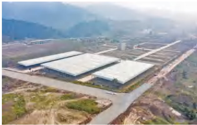
正在建设的广安建材城
