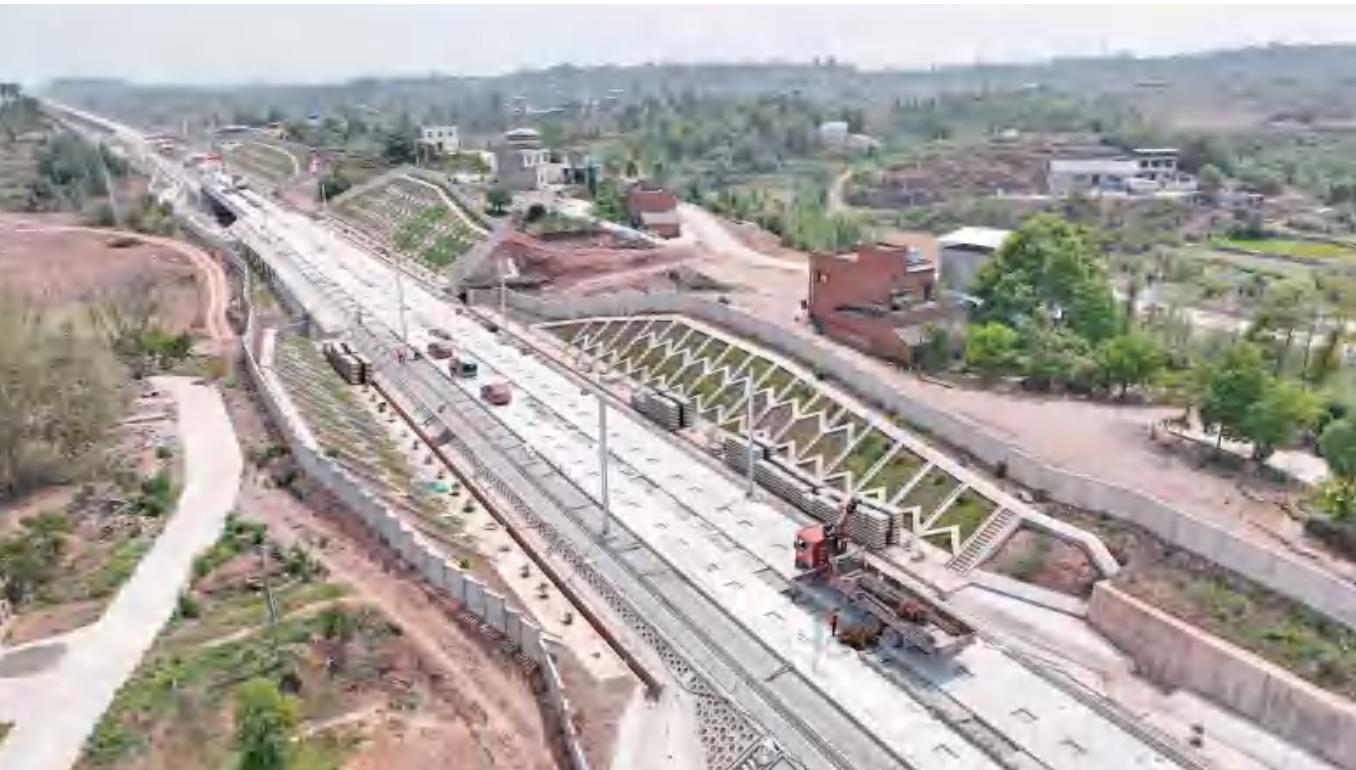
中铁十二局承建的渝昆高铁川渝段站前三标段线路全长38.9公里,主要包括桥梁43座,路基46段,制、架箱梁959孔,隧道2座以及无砟轨道等工程(其中重庆市永川段双线无砟轨道7.6公里)。
