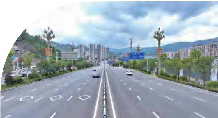
城市基础设施建设完善——彭水舵水大道
